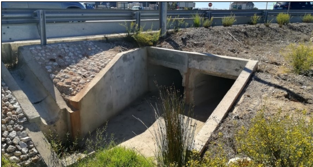
Figura 5. Passagem hidráulica na área de acesso ao LUES
