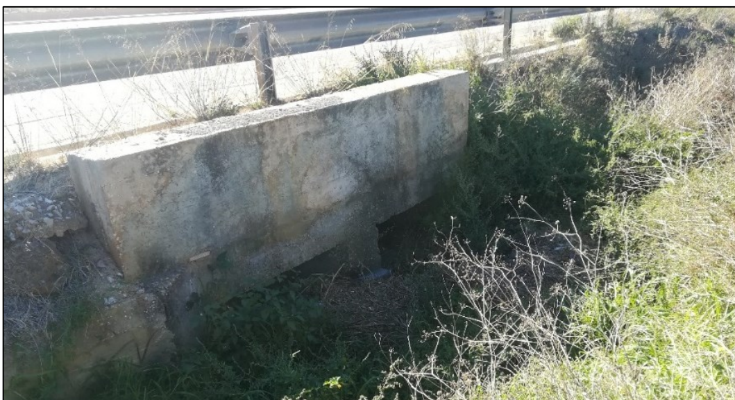
Figura 6. Passagem hidráulica sob a ER 125
